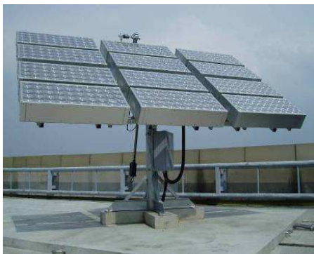
圖 2：1.5kW 屋頂型 HCPV 系統--蔚華科技大樓
